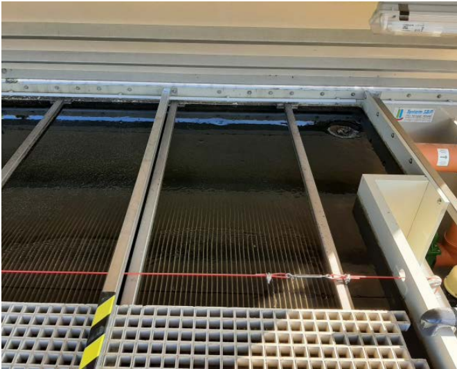
Bild 2: Technologie mit vollständig getauchten Scheiben, übersichtlich und gut zugänglich (Leutershausen Brunst, Bayern)
